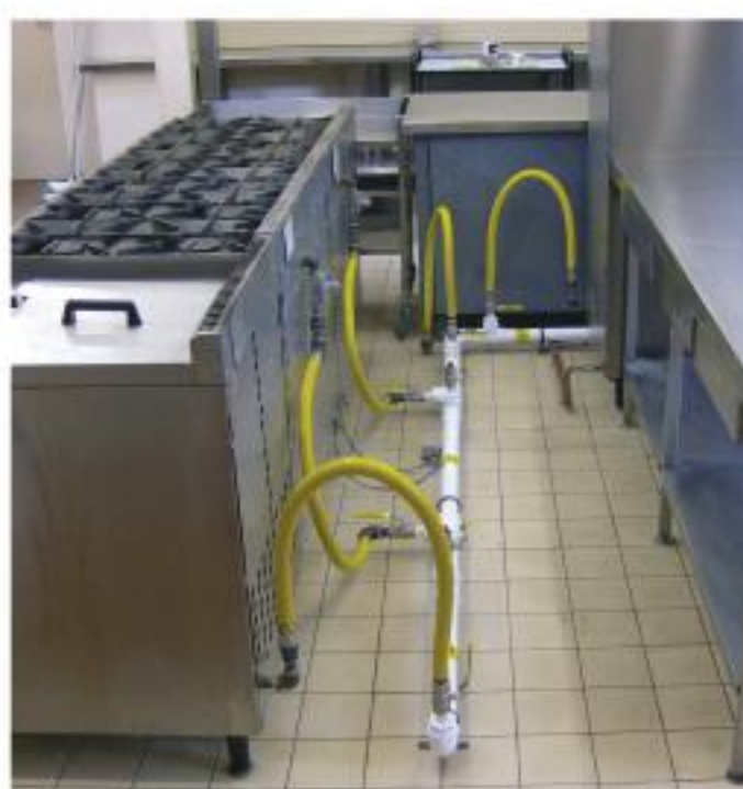
Gas Pipe Line Model : REC-150 GPL
